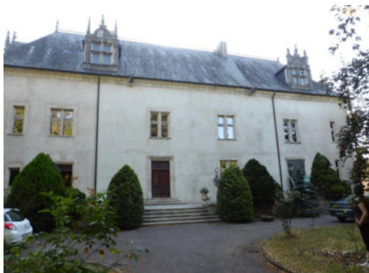
Le château de Choiseul à Stainville a bénéficié d'une aide de 1 892€ pour la réparation de la couverture en ardoises
